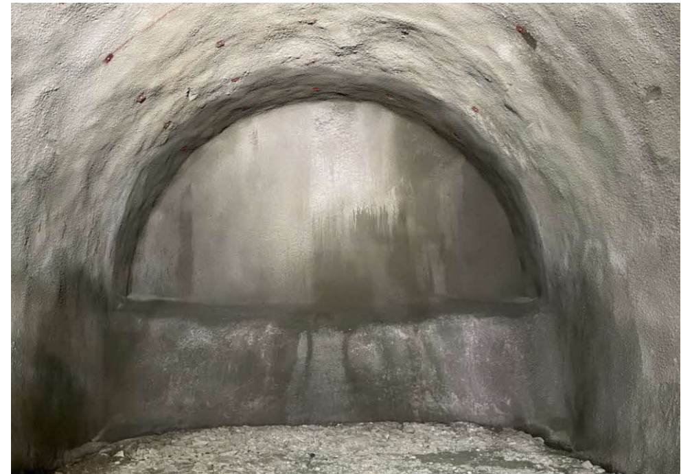
掘削完了地点の状況
