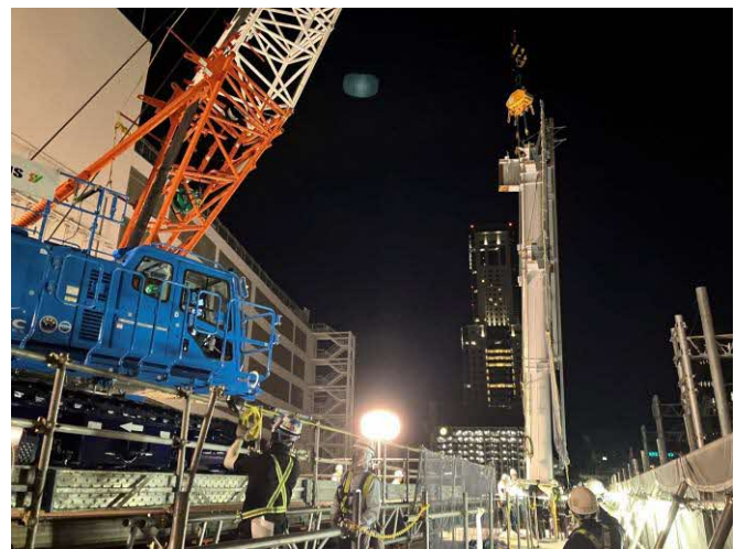
鉄骨建方工事の様子 最初に柱部材鉄骨の建て込みを90tクレーンを使用して行いました。
