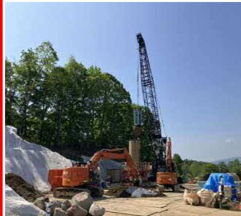
岩塊撤去状況
