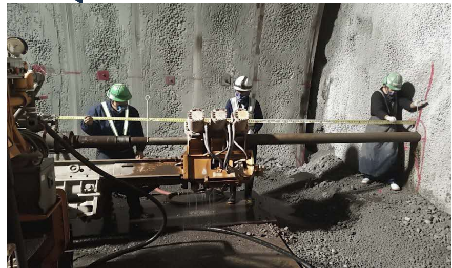
水平ボーリング実施状況
