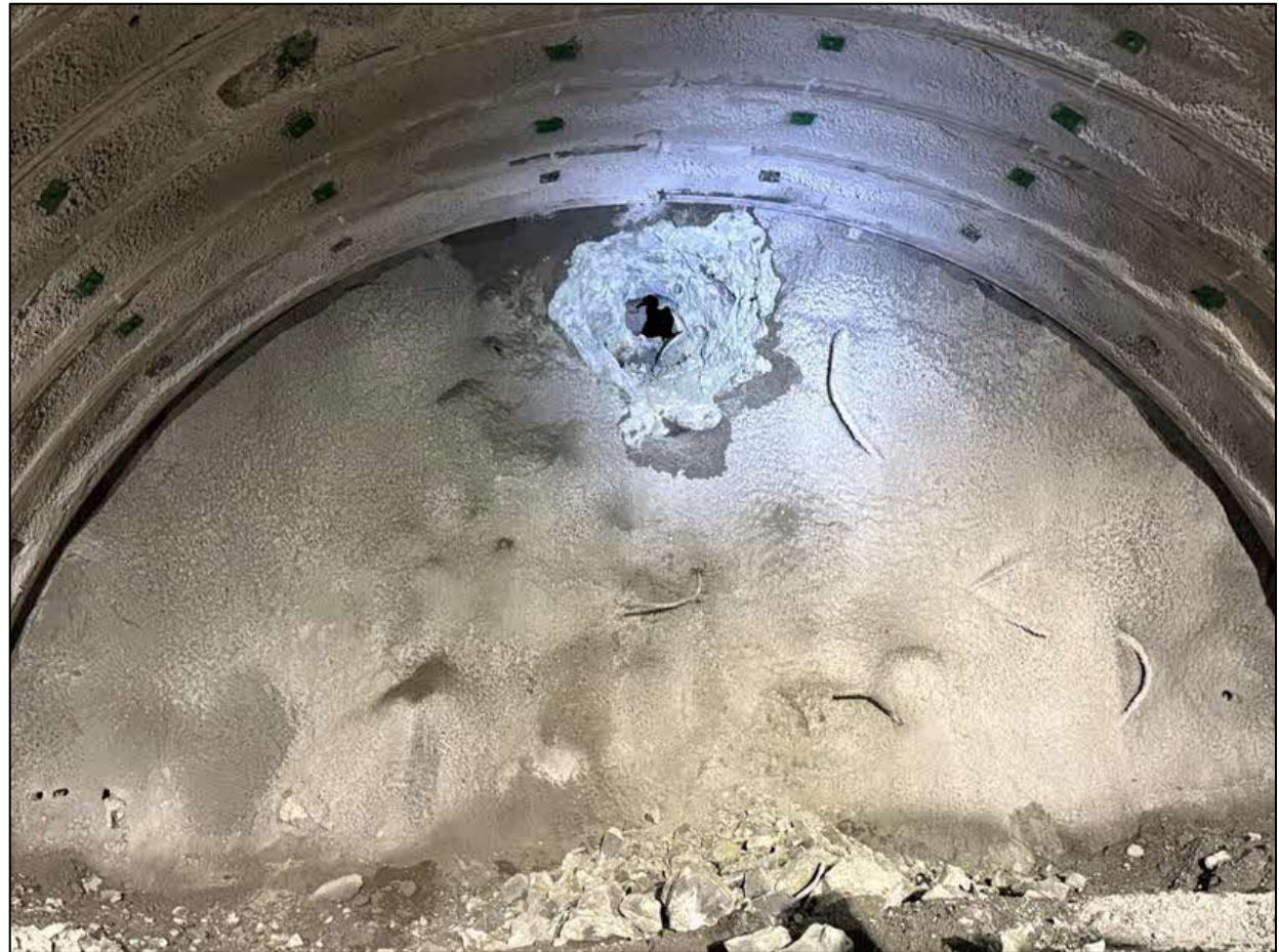
掘削完了地点の状況
