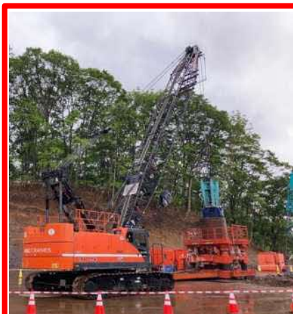
岩塊撤去状況
