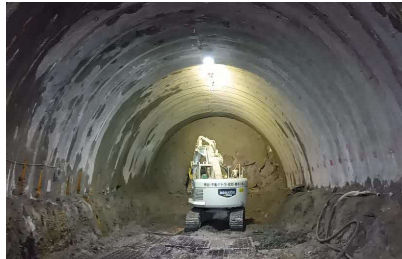
NATM掘削状況
