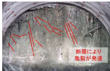
【特徴1】断層運動に伴う弱部の形成
