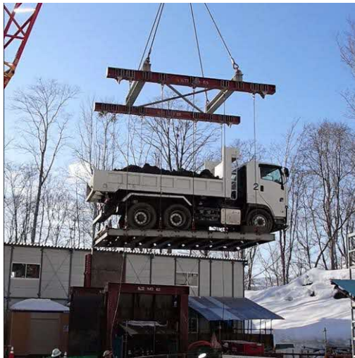
発生土搬出状況(到達立坑部(地上部))
