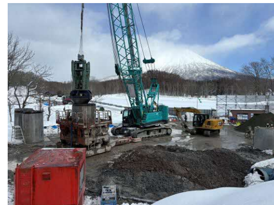
岩塊撤去状況
