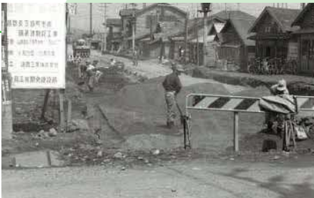
舗装中の市街地（旧国道）（昭和37年）
