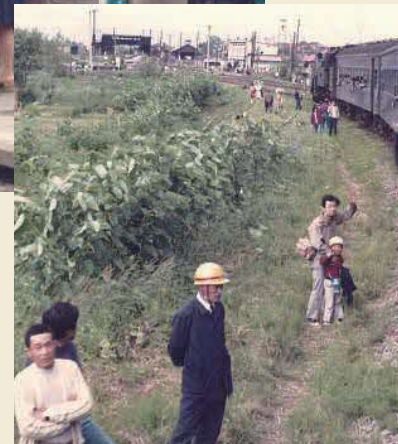
瀬棚線廃止イベント・ 国縫駅周辺で見送りする人々 昭和62年
