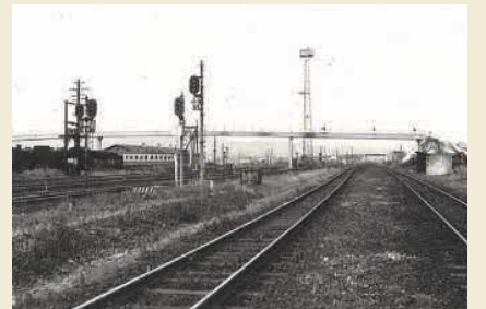
温泉と元町を結んでいた中央跨線橋
