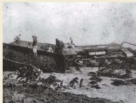
長輪線脱線事故 昭和4年
