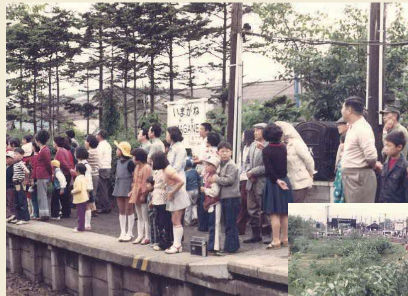
瀬棚線廃止イベント・今金駅ホーム 昭和62年
