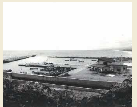
静狩漁港完成 昭和59年
