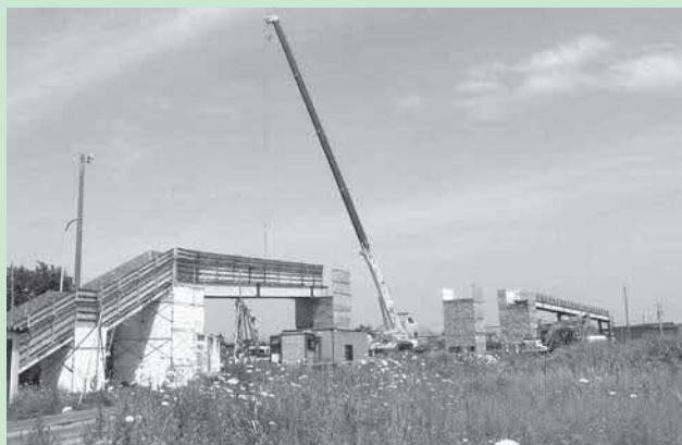
↑長万部中央跨線橋解体の様子（元町地区）
