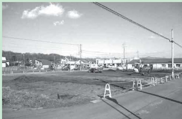
↑南部団地解体の様子（新開地区）
