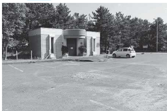
現在使用休止している公衆トイレ
