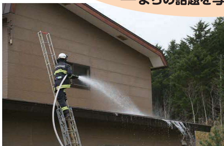
消防による飛散水清掃のための放水作業(9月6日)
