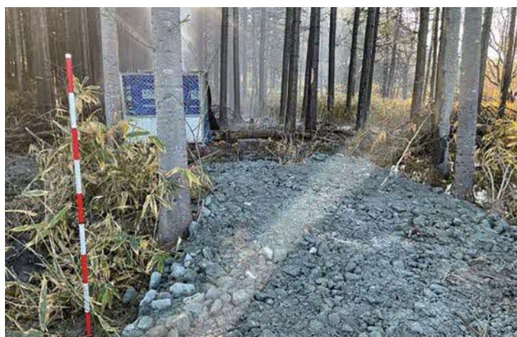
大型サイレンサー設置のための作業道整備(9月12日)
