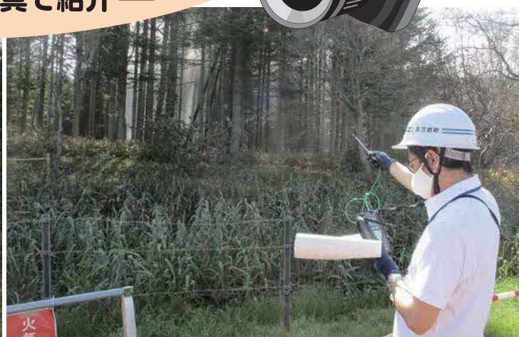
ガス検知器による安全確認作業
