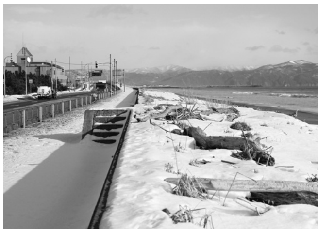
砂が堆積する防波堤
