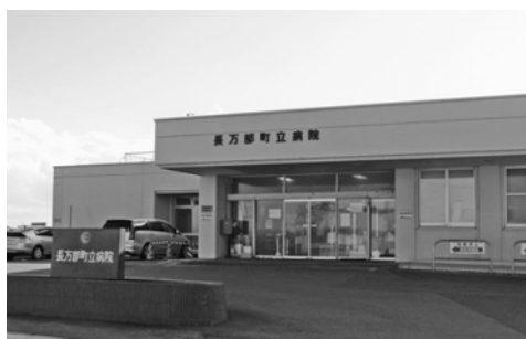
老朽化が進む町立病院
