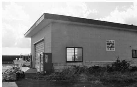
国縫漁港に設置の防犯カメラ
