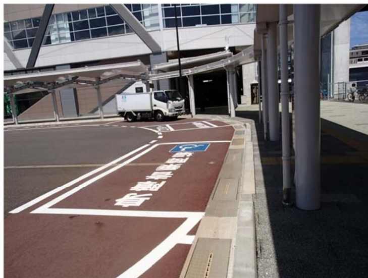
【事例】バリアフリーに配慮した駅前広場（北陸新幹線糸魚川駅）
