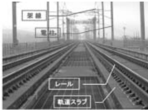
電気工事とは：電車に電気を供給する設備や電車をコントロールする設備などの工事
