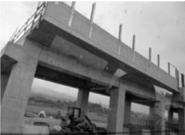
〔北海道新幹線建設工事状況：北斗市〕
