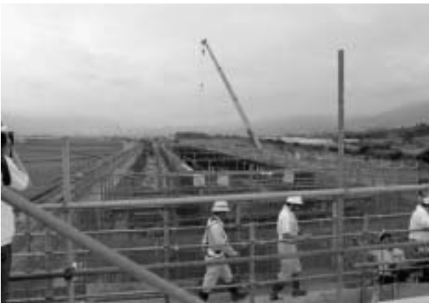
〔北海道新幹線建設工事状況：北斗市〕
