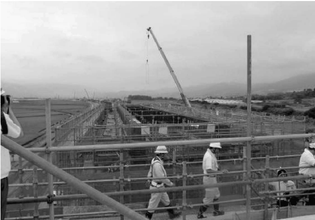
〔北海道新幹線建設工事状況：北斗市〕
