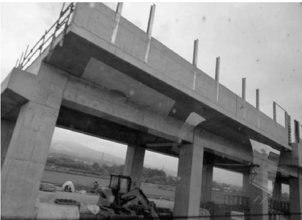
〔北海道新幹線建設工事状況：北斗市〕
