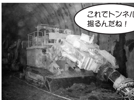
【トンネルの掘削機】
