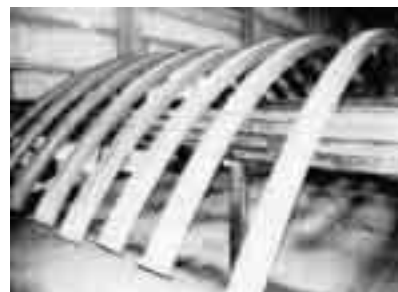
【アールシーサンコー社が製作する高架橋などの杭などに使用される鉄筋カゴ】
