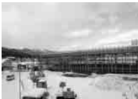
新函館（仮称）駅終点側
