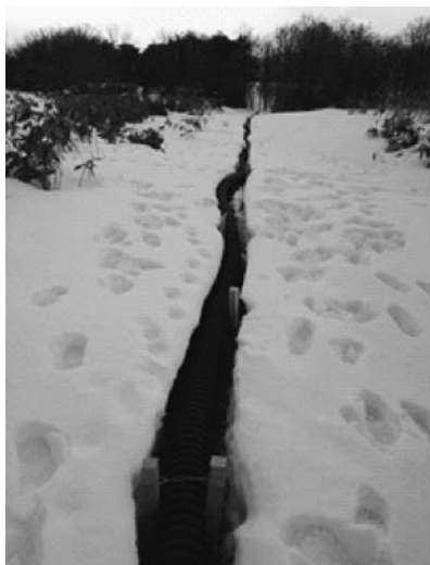
写真：温泉配水管敷設状況
