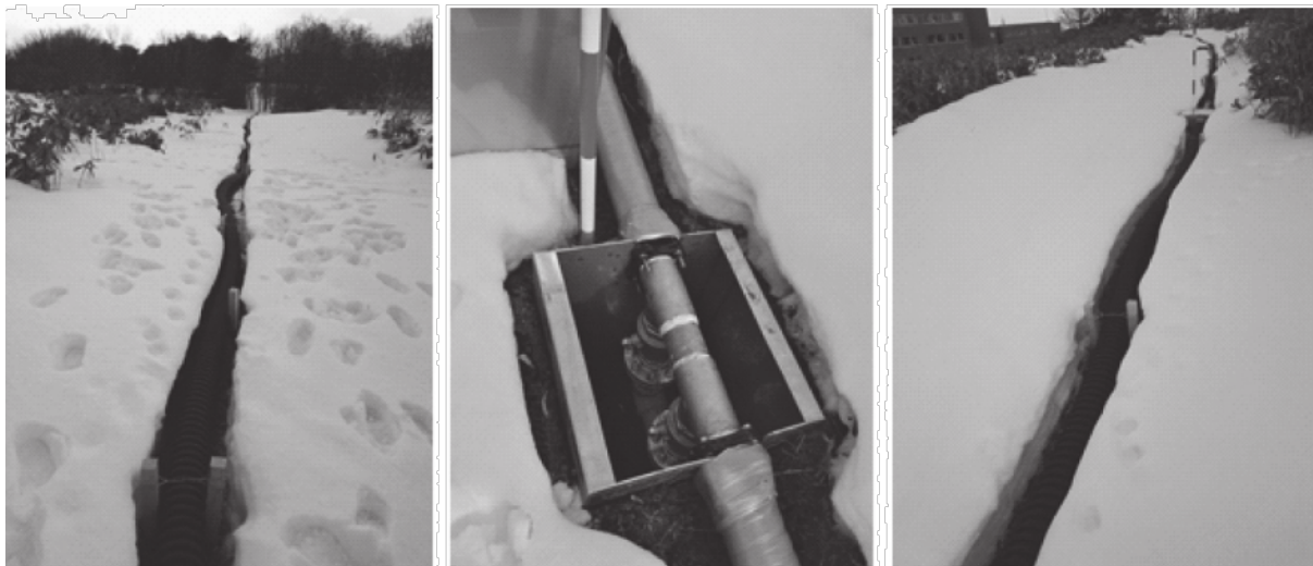
写真：温泉配水管敷設状況
