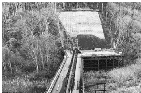
内浦トンネル（静狩）他工区入口
