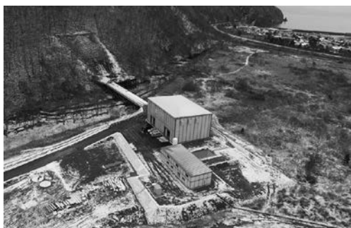
内浦トンネル（静狩）他工区工事現場全景
