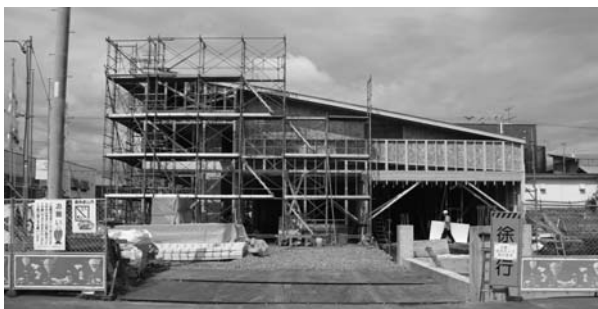
建設中の多目的活動センター（仮称）
