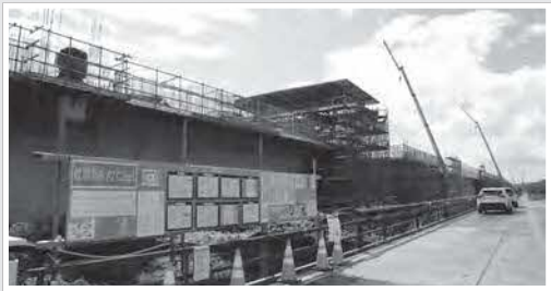
←町内工事の様子
