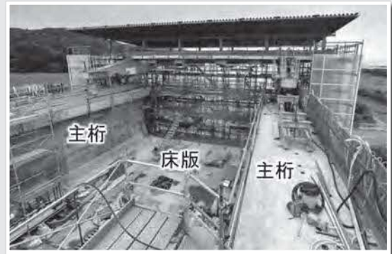
第5国縫Bv内部の状況（7/8撮影）
