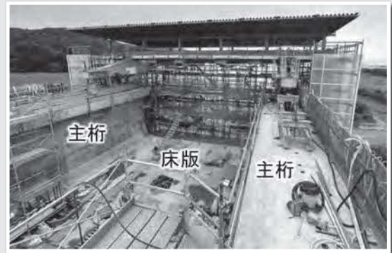
第5国縫Bv内部の状況（7/8撮影）
