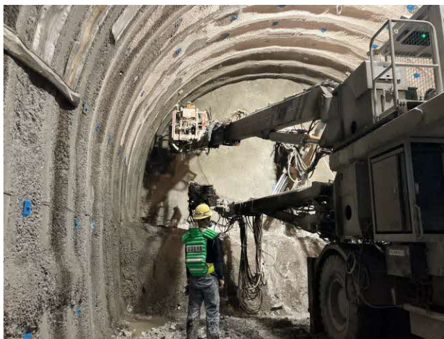
札幌トンネル(銭函) ロックボルト施工状況 (新函館北斗方を望む)
