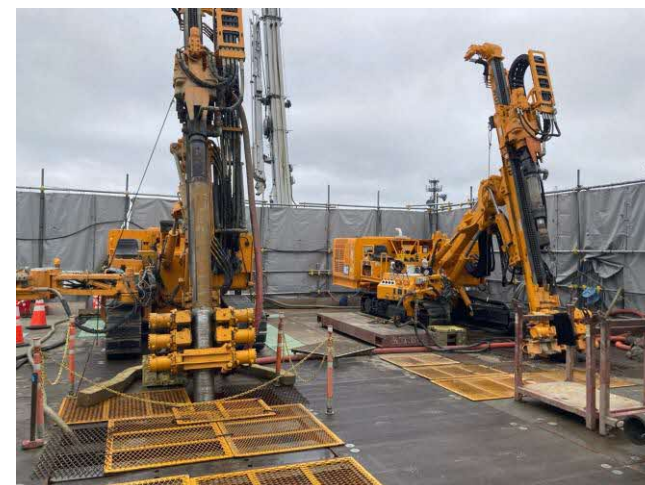
凍結管埋設の様子
