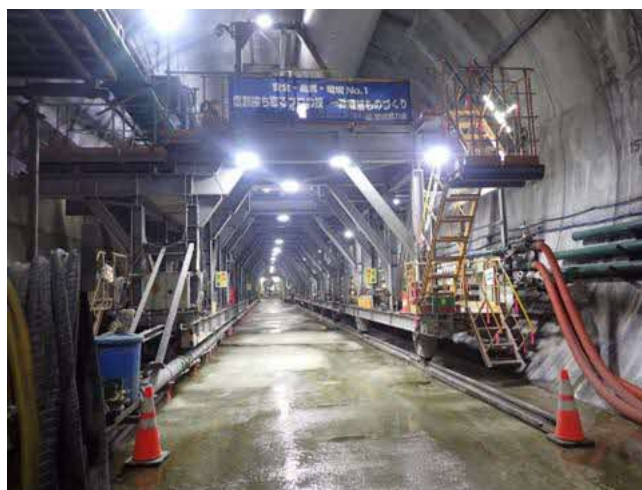
羊蹄トンネル(有島) シールドマシン後部状況
