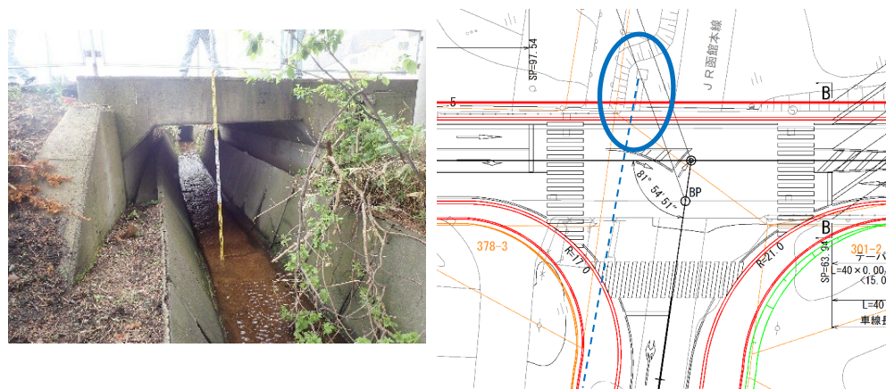
図 4-5 既設 BOX カルバート
