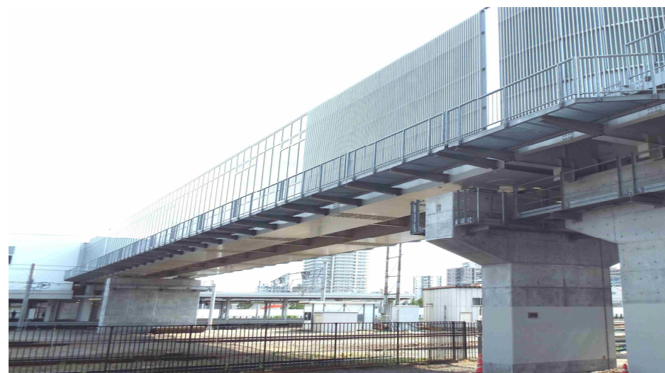
写真 跨線人道橋（箱桁橋）の例
